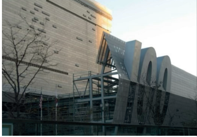
Ilustración 2. Federal Building de San Francisco. Fachada se compone de diferentes materiales, entre ellos, 4645 m2 de paneles de aluminio con costura.
