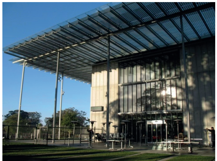
Ilustración 3. California Academy of Sciences. Golden Gate Park, San Francisco. Se utiliza aluminio en diferentes partes del edificio, principalmente en la cubierta.
